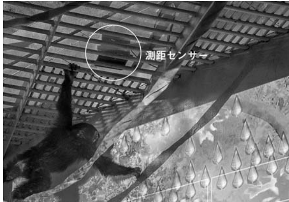
図4 天井下に取り付けられた測距（赤外線）センサー
